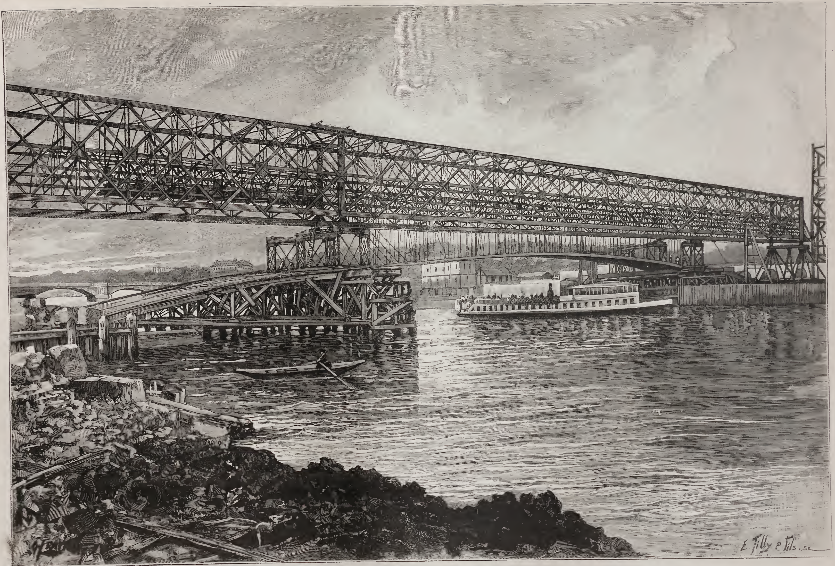
MONTAGE DU PONT ALEXANDRE III. — Vue générale de la passerelle et du cintre.
